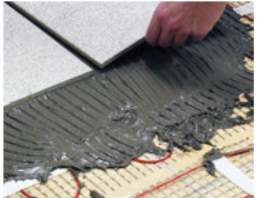
Работы, связанные с нанесением плиточного клея, требуют соблюдения определенного температурного режима (от +5 °С до +25 °С). Это требование относится как к температуре основания, так и к воздушной среде. Аналогичный температурный режим должен сохраняться и на протяжении времени, необходимого для отверждения плиточного клея. Проследите за тем, чтобы во время проведения указанных работ в помещении не было сквозняков. Грунтовка укрывающего слоя осуществляется после полного высыхания последнего.
